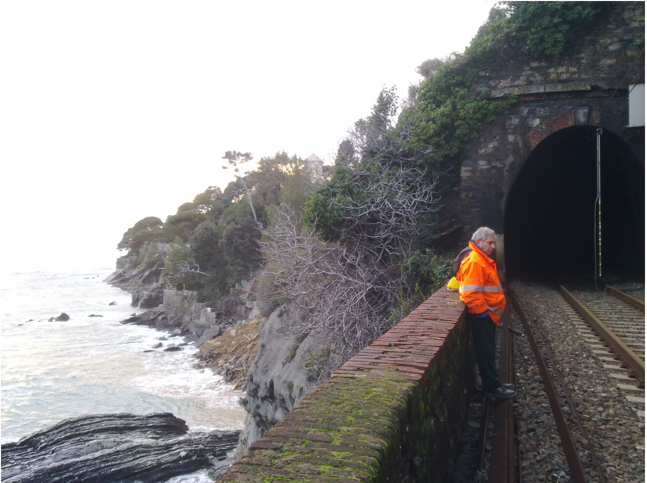
Imbocco della galleria Liggia 1 lato La Spezia – a sinistra il piede della frana
